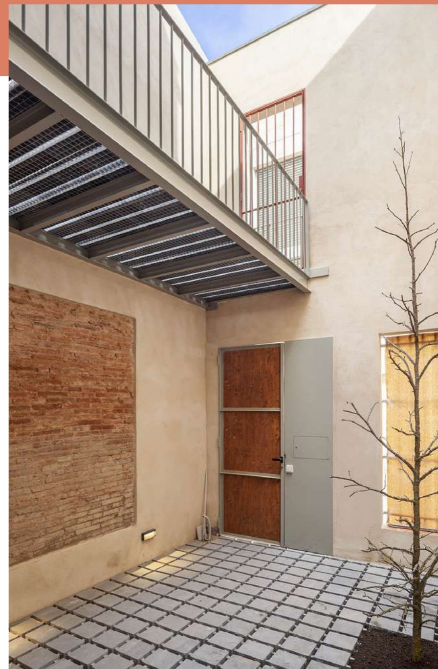
Architecte SausRiballLonch. Entrepreneur: House habitat.
